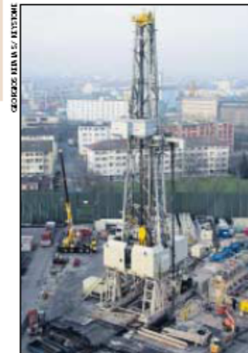
Bohrturm in Kleinhüningen.
